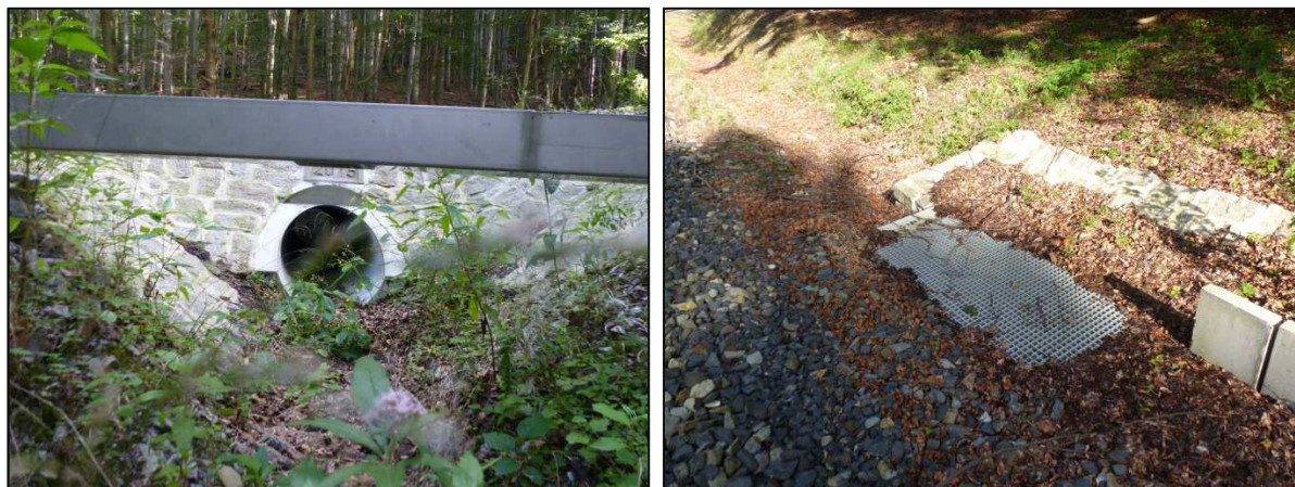
Obr. 29 a 30: Propustek v Karlovských bučinách, podle zobrazeného letopočtu opravený v roce 2015, je z jedné strany otevřený. Tentýž propustek je ale na druhé straně koleje překrytý mříží a z hlediska obojživelníků zaslepený. Toto řešení může vytvářet nebezpečnou past.
