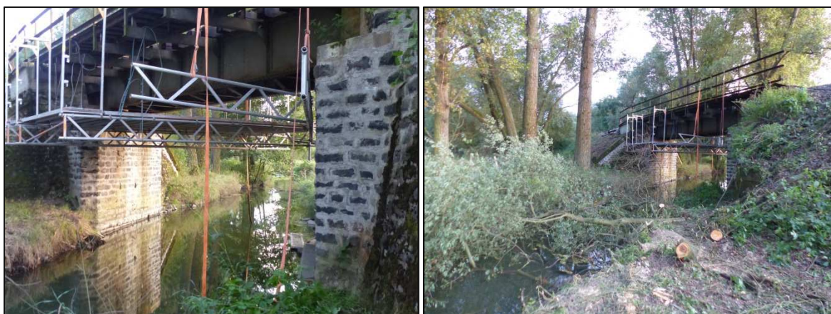
Obr. 14: a 15: Most přes Panenský potok u obce Tlustecká. Z hlediska migrační prostupnosti se jedná o nevhodné řešení, neboť voda pod mostem zasahuje od stěny ke stěně a neumožňuje suchý průchod.
