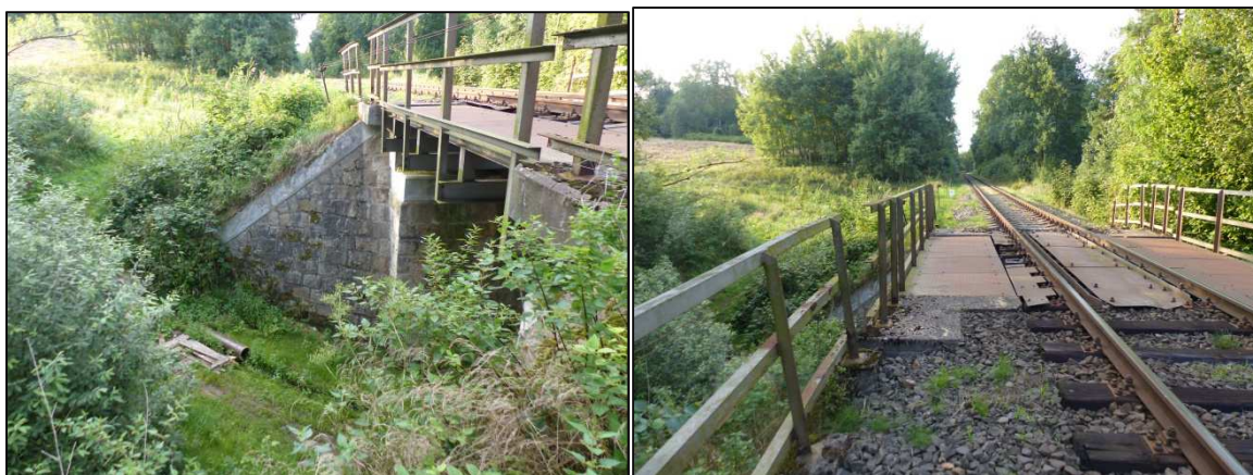
Obr. 12: a 13: Přemostění drobné vodoteče mezi Mimoní a Pertolticemi pod Ralskem. Most splňuje parametry pro migrační prostupnost, neboť umožňuje suchý průchod po březích toku.
