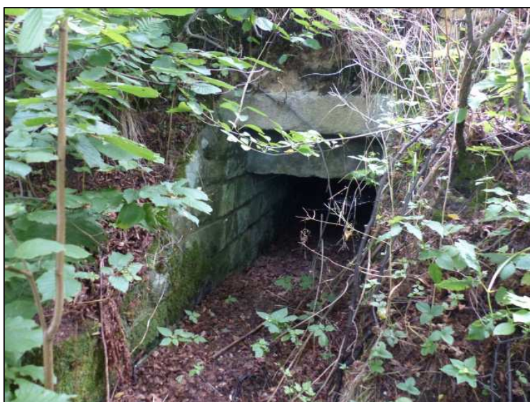
Obr. 11: Rámový propustek v úseku mezi Mimoní a Pertolticemi pod Ralskem. V době průzkumu byl propustek hustě zarostlý rudерální vegetací.
